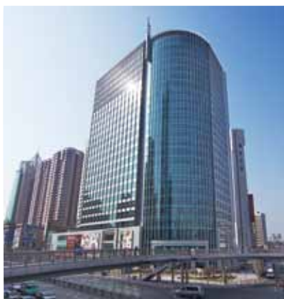
恒匯國際大廈(閘北區—上海市)
